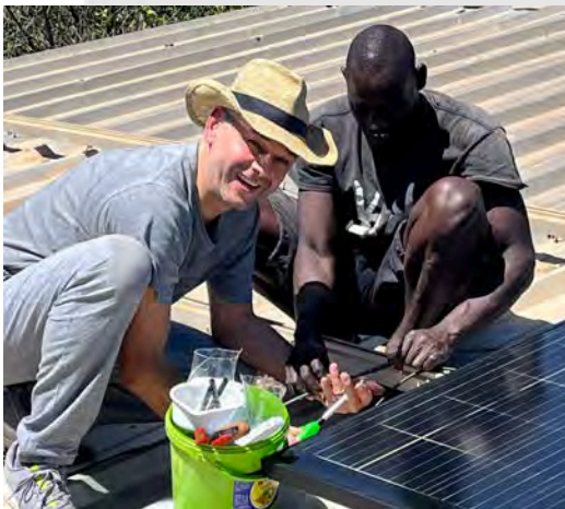
Montage der Solarmodule - Alex / Kebba
